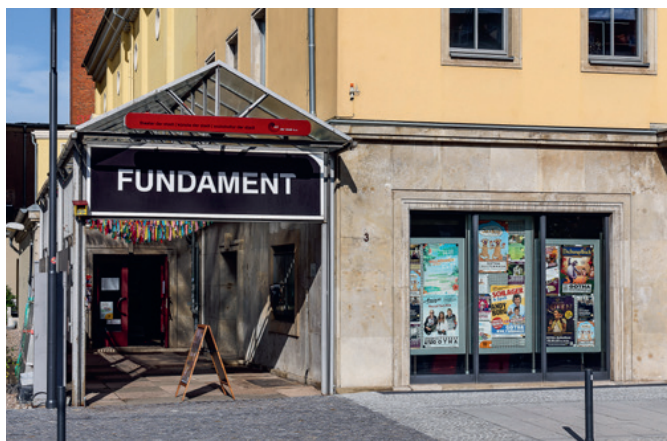
Eingang zum FUNDAMENT im Keller des Gothaer Kulturhauses.
