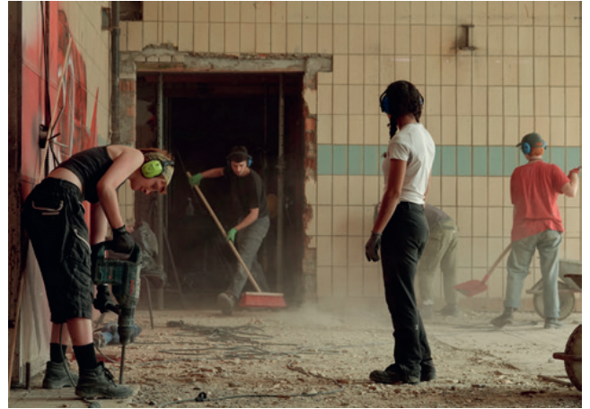
Die umfassenden Baumaßnahmen wären ohne die vielen Freiwilligen nicht zu stemmen gewesen.
