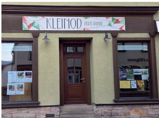
Das KLEINOD entstand in einem leerstehenden Ladenlokal in der Ilmenauer Innenstadt.
