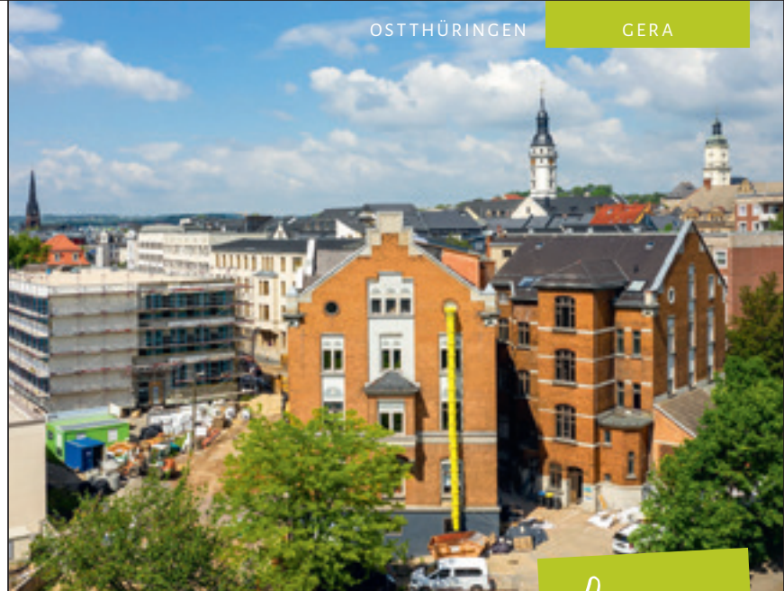
Das Gebäude der ehemaligen Mädchenschule wird seit 2016 schrittweise saniert. Foto: Thomas Müller
